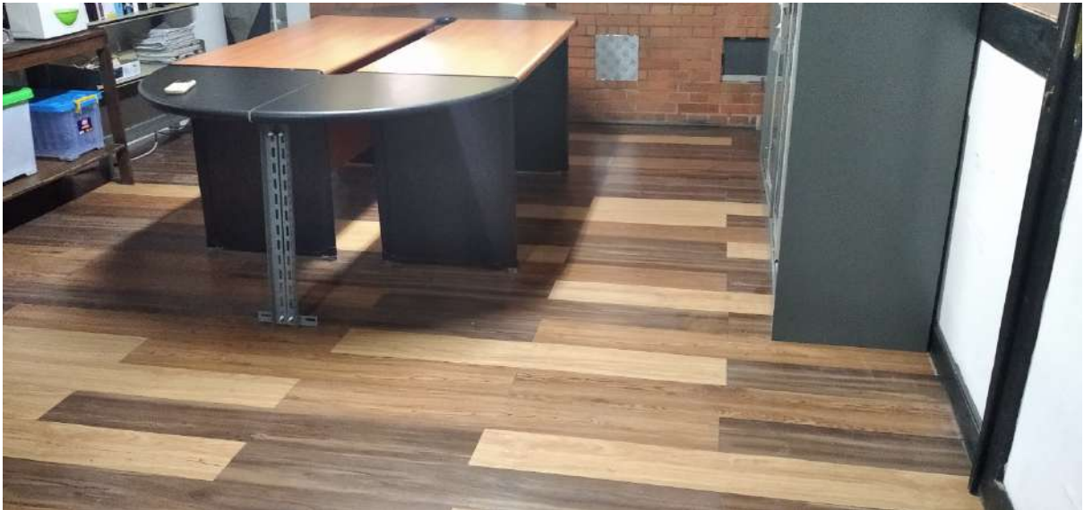
Gambar 161 Perbaikan Lantai di Ruang Mahasiswa lantai 3 Gedung B DTM FTUI
