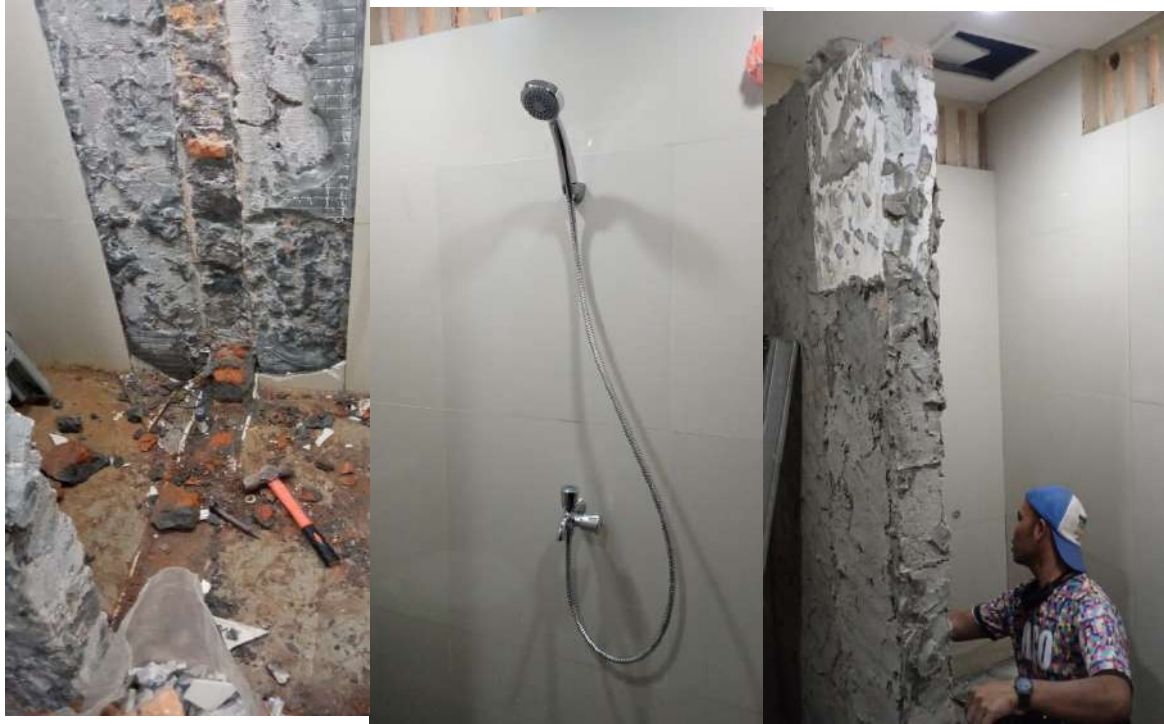
Foto renovasi sebelum dan sesudah kamar mandi Mahasiswa lt. 1
