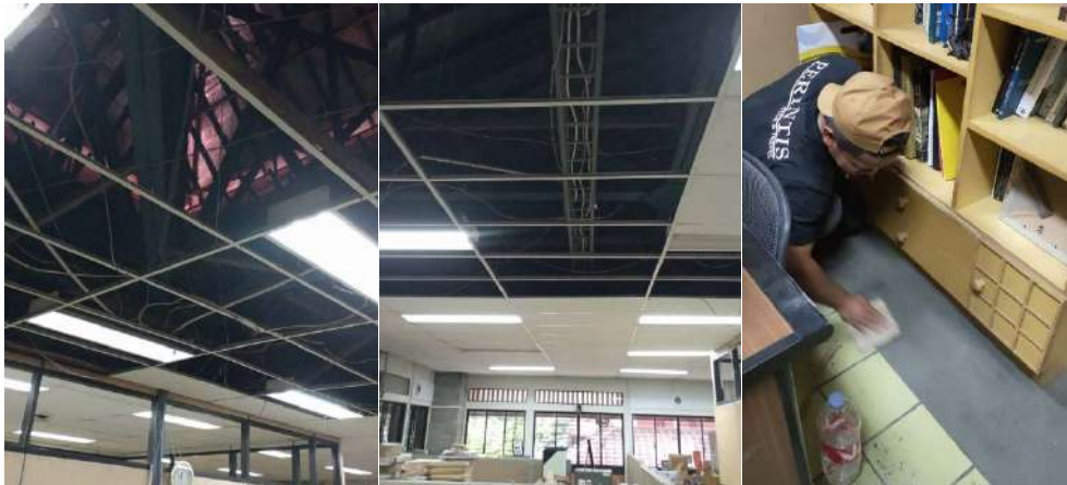
Gambar 199 1) Pembongkaran plafon ruang kerja (kiri); 2) Pemasangan plafon gyptile (tengah); 3) Penambalan lantai keramik
