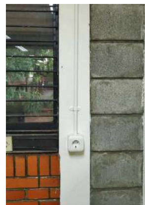
Gambar 201 1) Pemasangan lampu sorot Phillips (kiri); 2) Penggantian stop kontak
