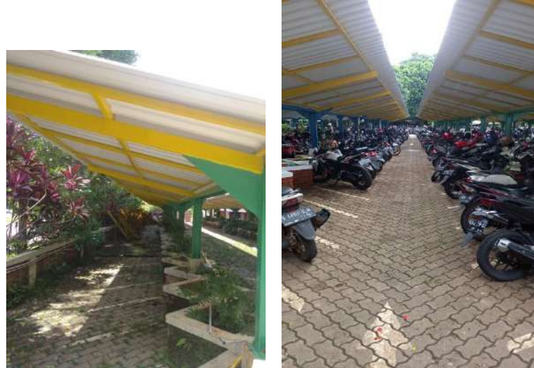
Gambar 28 Kondisi Parkir Motor Sesudah Renovasi
