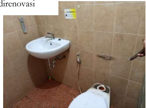
Foto sebelum direnovasi
