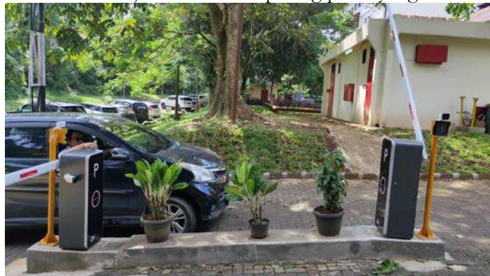
Gambar 31 Palang Pintu Otomatis area DTK dan Kantin
