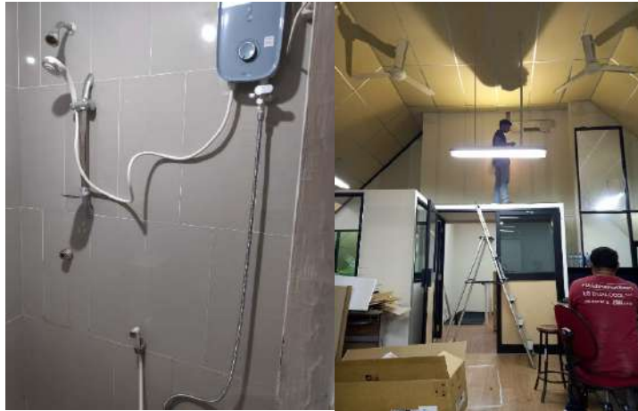
Gambar 202 1) Pemasangan water heater (kiri); 2) Penambahan AC di studio program profesi
