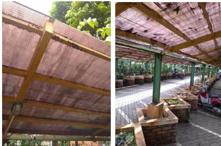
Gambar 27 Kondisi Parkir Motor Sebelum Renovasi
